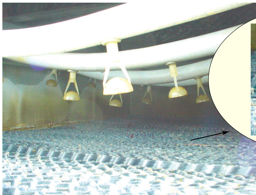
Présence de tartre dans un corps d'échange
