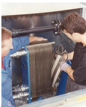
*Figure 1J : Assemblage d'un échangeur à plaques*
